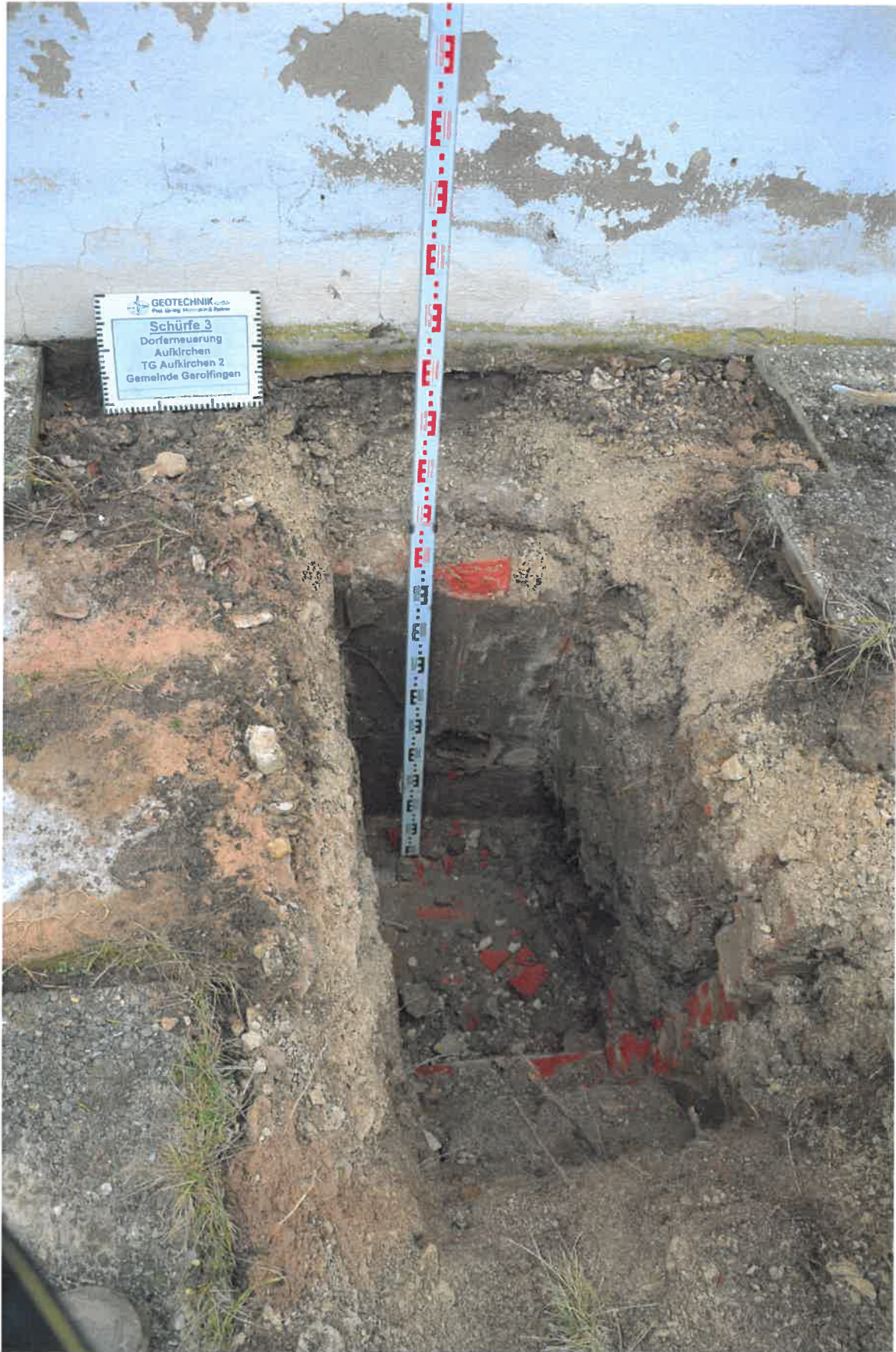
Bild 11: Schürfe 3 am Fundament Altes Rathaus Nordseite, benachbart zum Giebel Westseite
