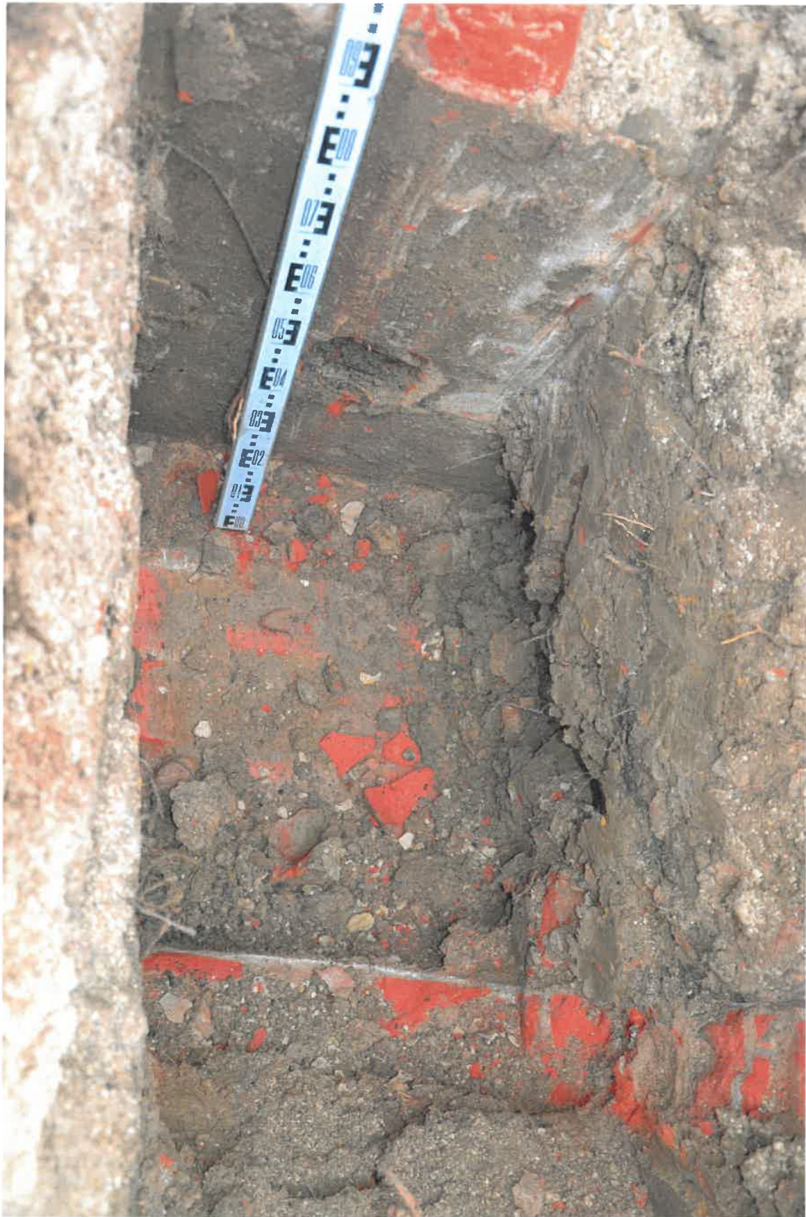
Bild 12: Schürfe 3, Detailaufnahme ehem. Schacht/ Kanal vor dem Fundament Südseite
