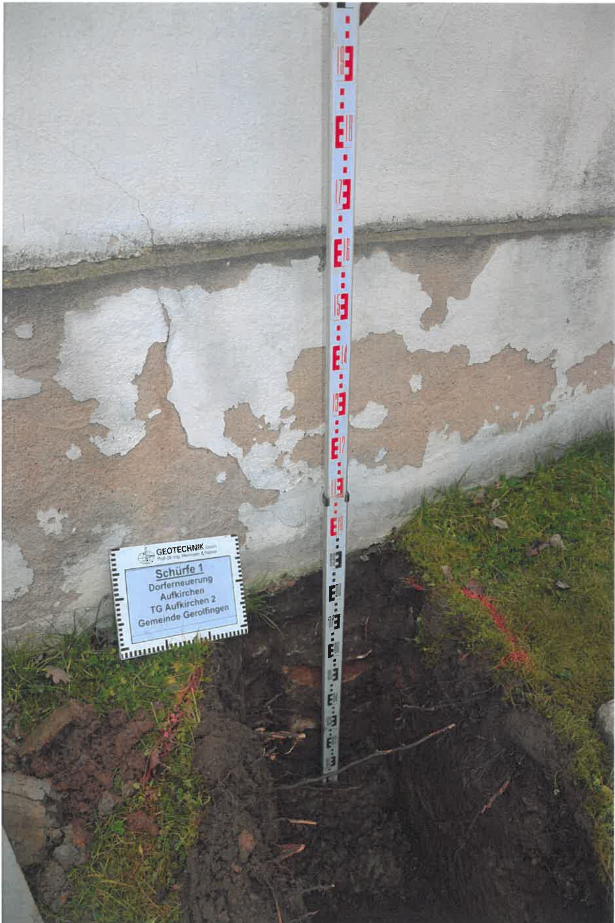
Bild 7: Schürfe 1 am Fundament Altes Rathaus Nordseite, benachbart zum Giebel Ostseite
