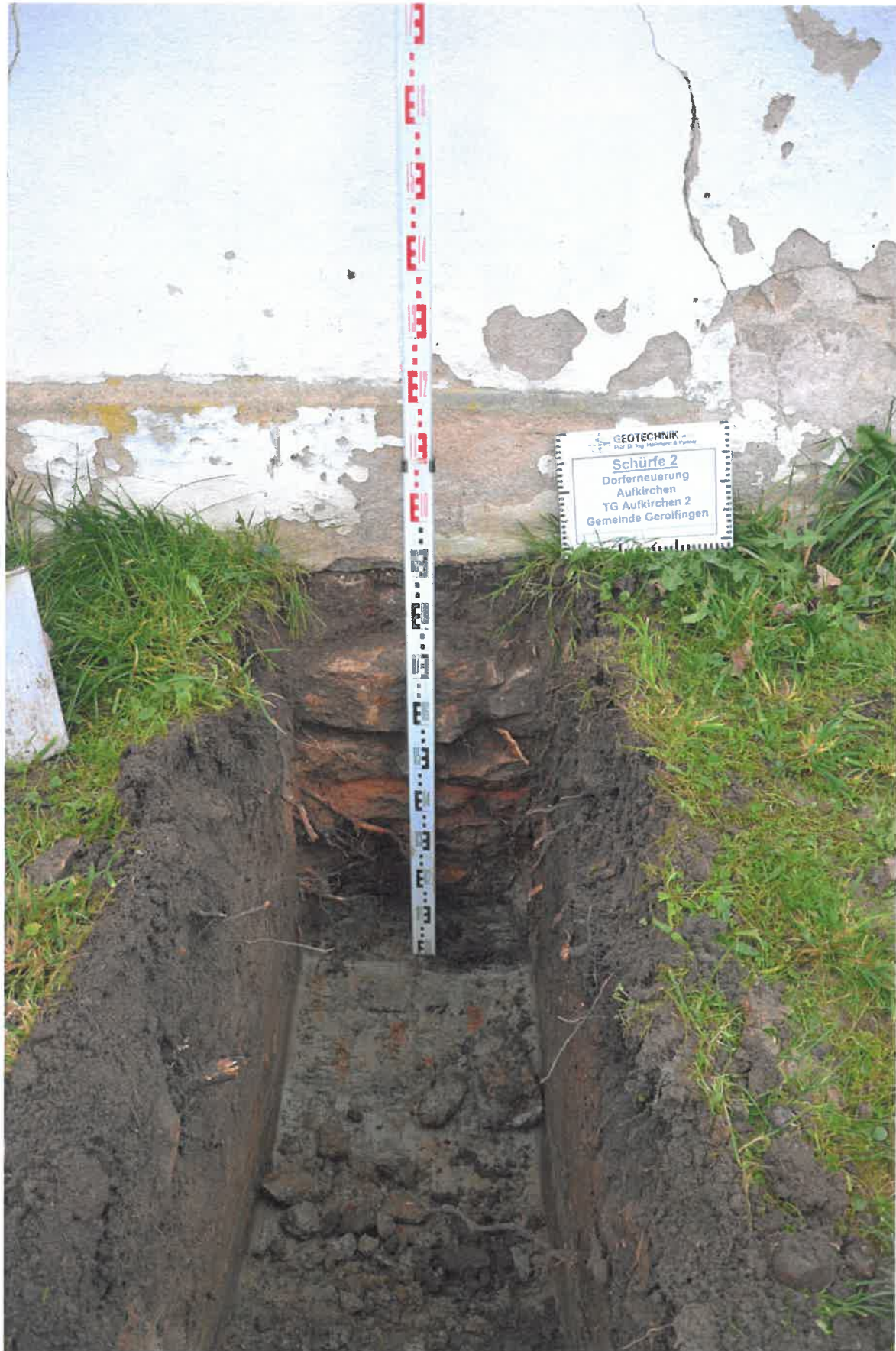
Bild 9: Schürfe 2 am Fundament Altes Rathaus Nordseite, benachbart zum Giebel Westseite
