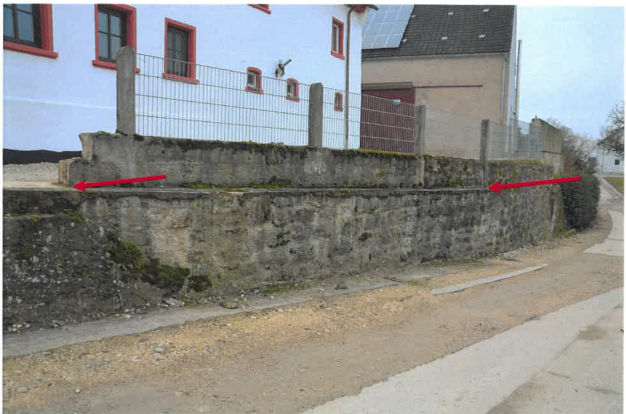
Bild 4: Stützmauer (Abschnitt 3) mit Abdeckplatte und aufgesetzten Mauer und Zaun; geplante Abbruchbereiche (UK) markiert
