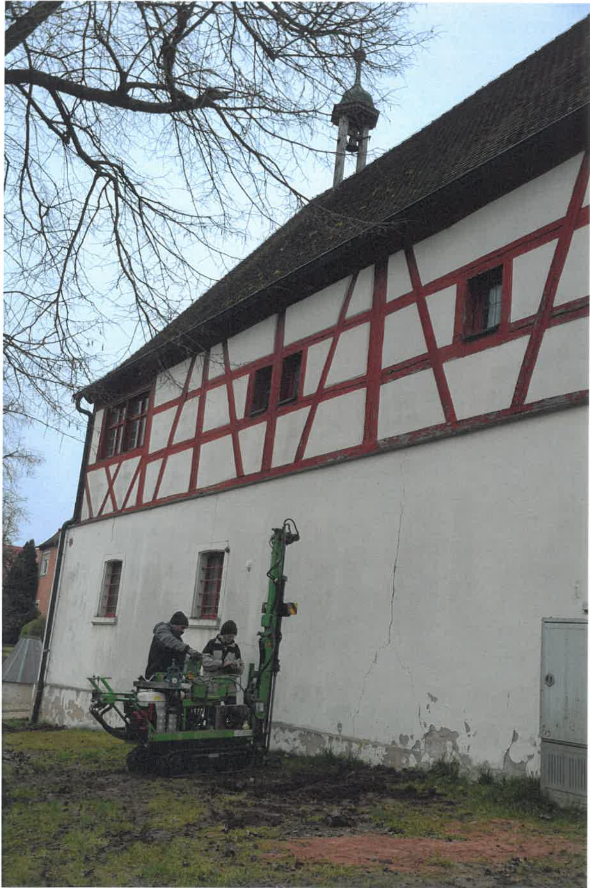
Bild 13: Sondierung DPH-7 an der Nordseite des Alten Rathauses
