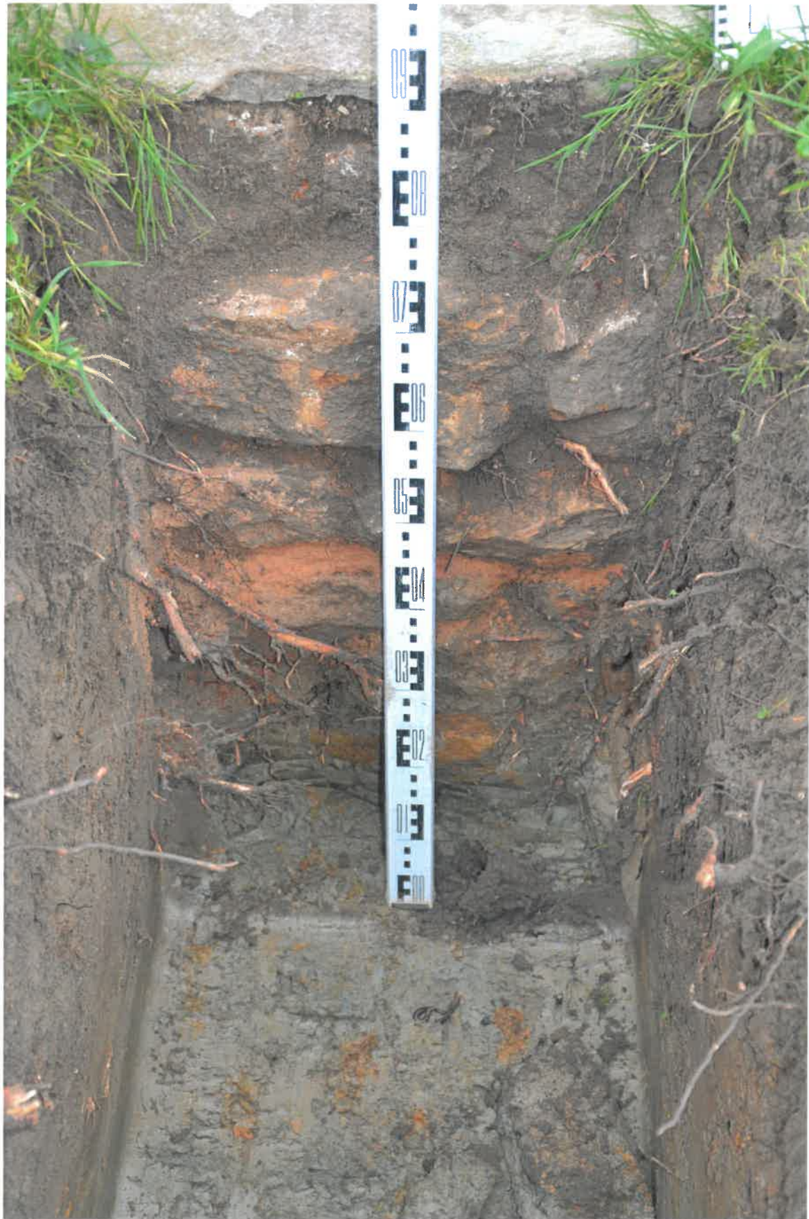
Bild 10: Schürfe 2, Detailaufnahme Fundamentmauerwerk, Wurzeln Baugrund
