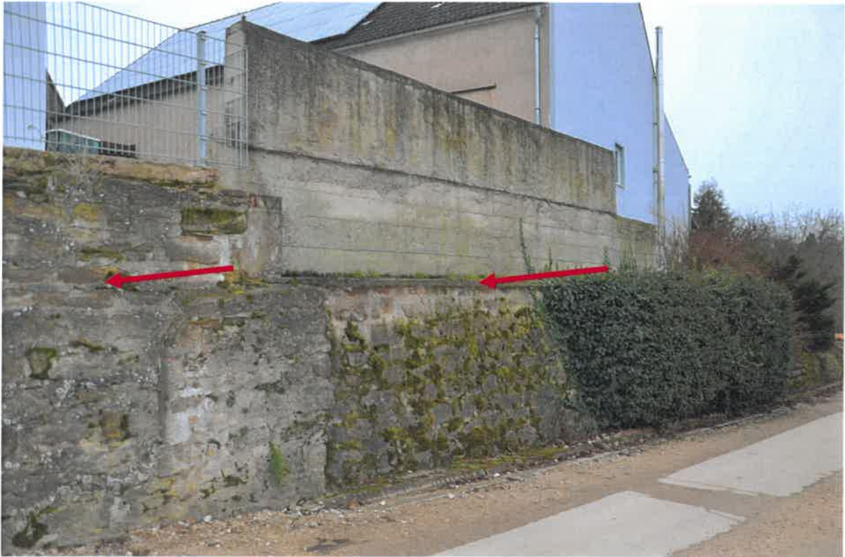
Bild 1: Stützmauer von 1956/1957 rechts, teil mit Bewuchs (Abschnitt 1) mit aufgesetzten Stahlbeton-Mauern; geplante Abbruchbereiche (UK) markiert
