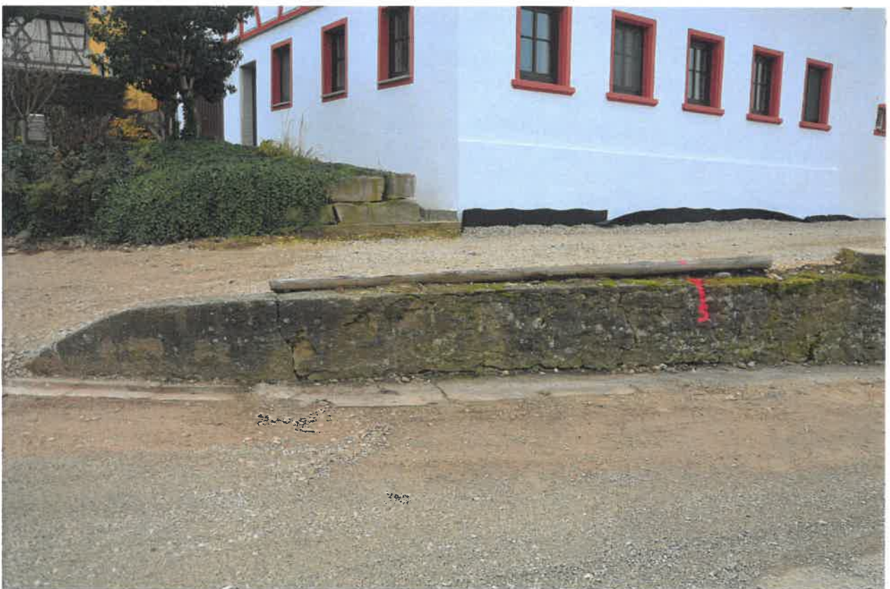
Bild 6: Stützmauer (Abschnitt 4) im Bereich der Rampe Hofzufahrt zur Straße
