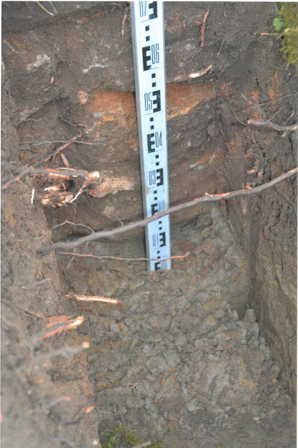
Bild 8: Schürfe 1, Detailaufnahme Fundamentmauerwerk, Wurzeln Baugrund
